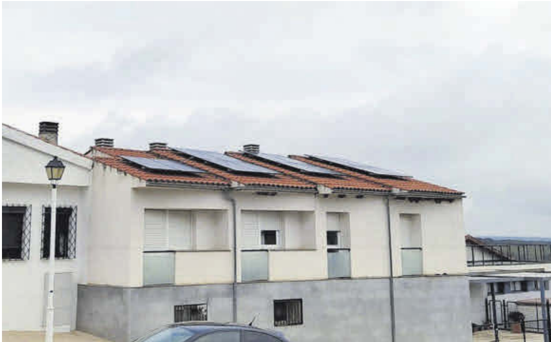
► Placas solares instaladas sobre el tejado de la residencia de mayores en Aliseda.
