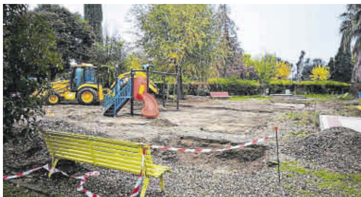
Trabajos de mejora en el parque municipal.
