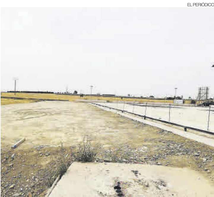
►► Infraestructura colocada con la primera fase de las obras.
