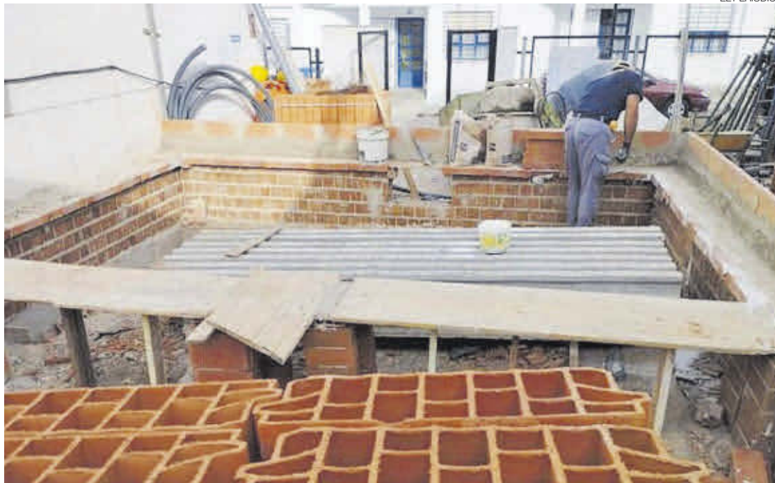
►► Trabajos que se realizan en las instalaciones del centro de día de Malpartida.
