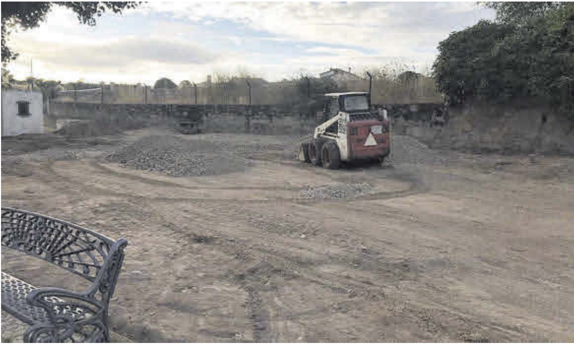
Una máquina trabaja en la zona de aparcamientos de la piscina municipal y el tanatorio.
