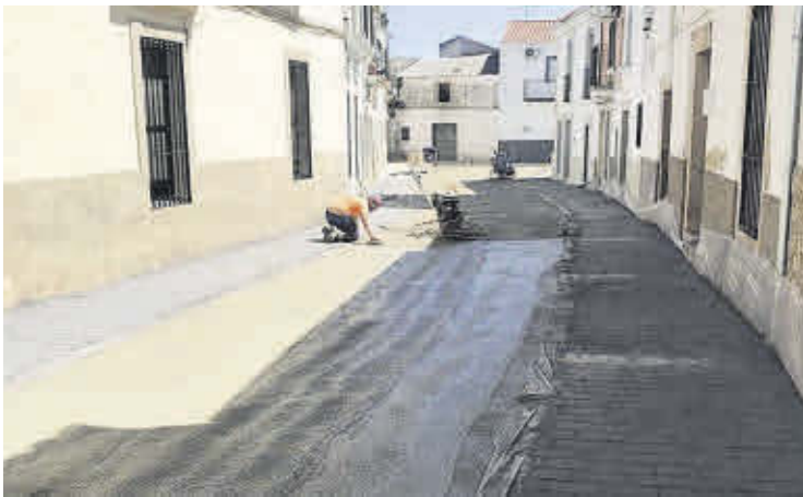
Obras en la calle Santo Domingo de Guzmán.
