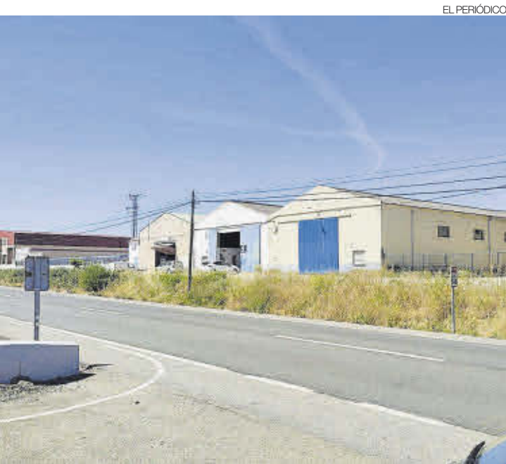
►► Naves ubicadas en el polígono industrial de Casar.
