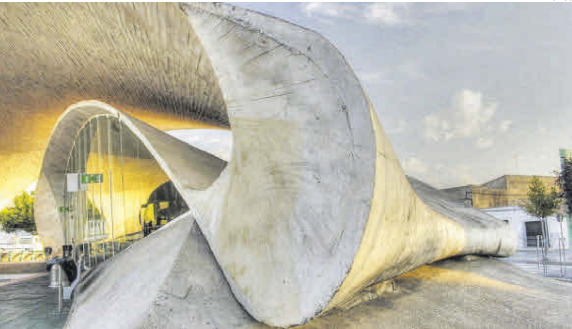
►► Estación de autobuses de Casar de Cáceres.
