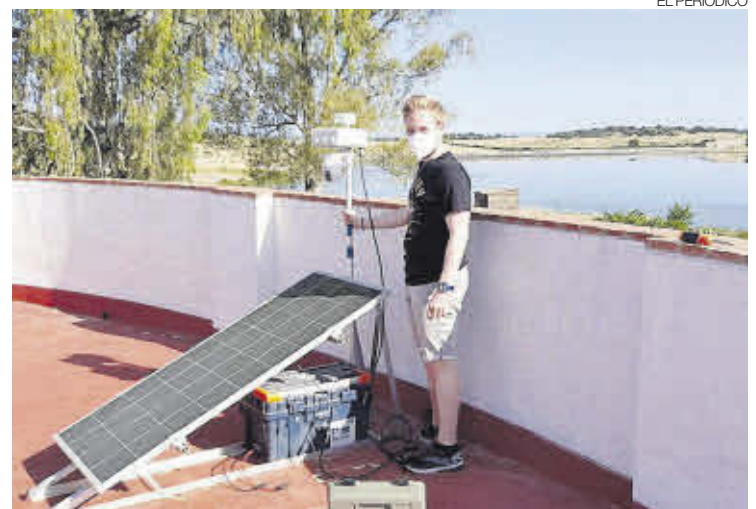
►► Instalación del medidor astronómico.
