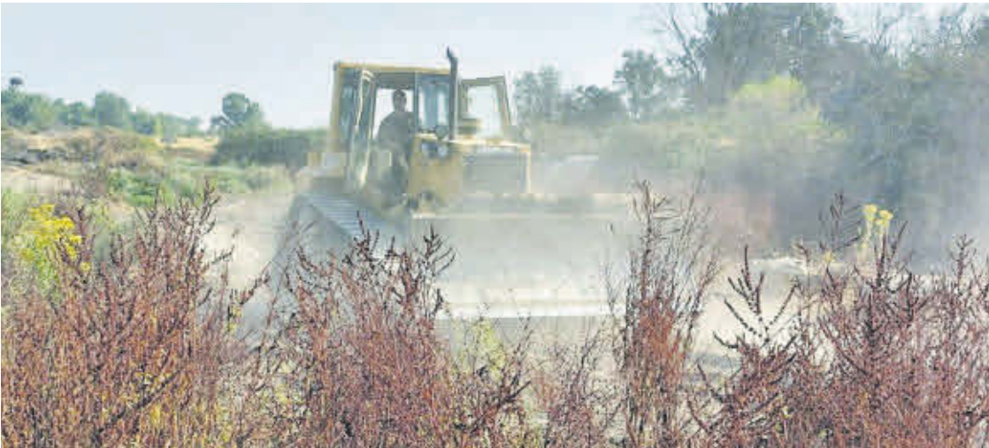
Una máquina realiza trabajos en la zona del humedal.
