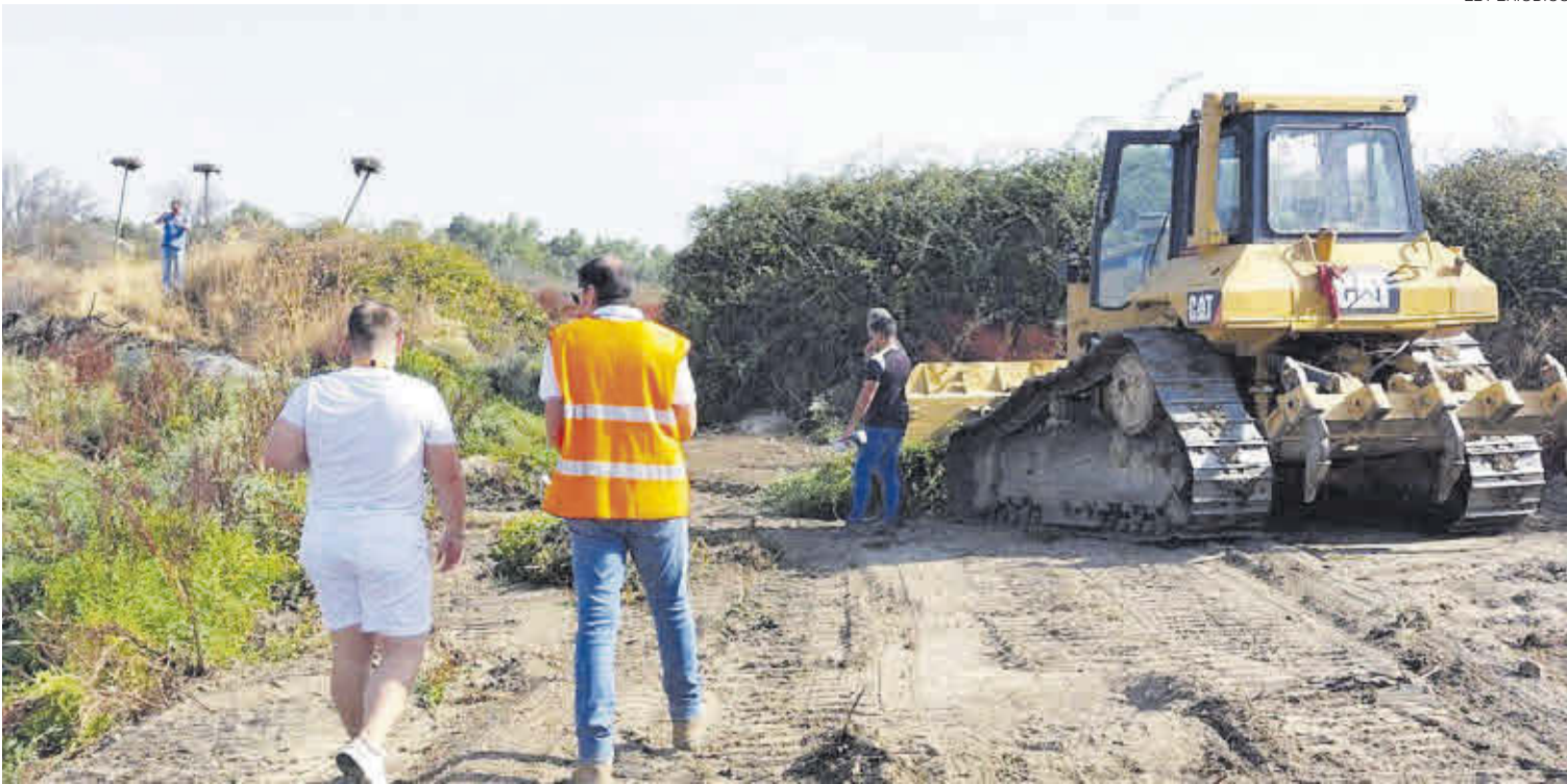
Técnicos y trabajadores de las obras, en los terrenos donde se ejecutan los trabajos.
