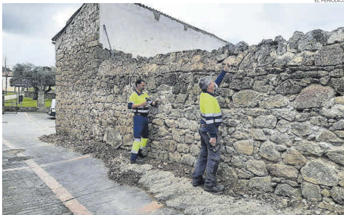
Dos operarios realizan labores en un muro de la casa rural del municipio, en una imagen de archivo.
