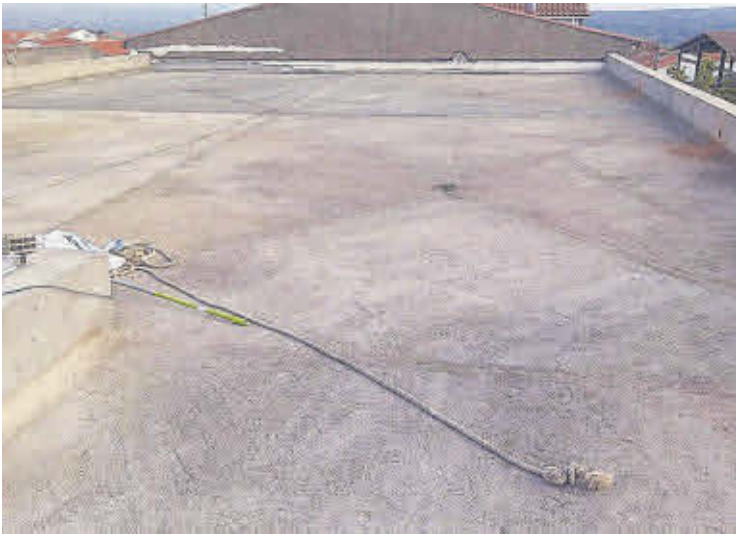
Reforma de la cubierta del salón multiusos.
