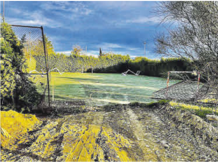
Arreglo del suelo del polideportivo.
