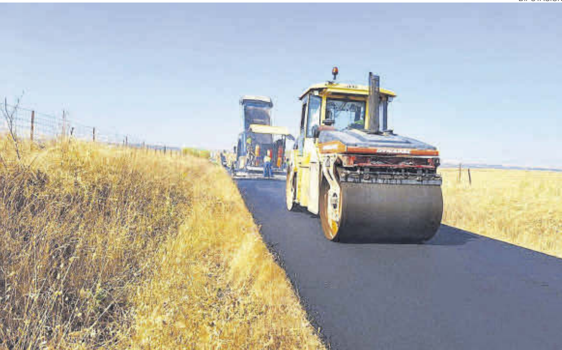
Operarios y máquinas trabajan en una de las carreteras con obras de la diputación.
