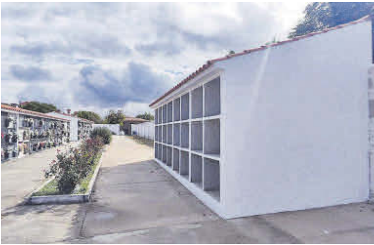
Zona de los nuevos nichos construidos.
