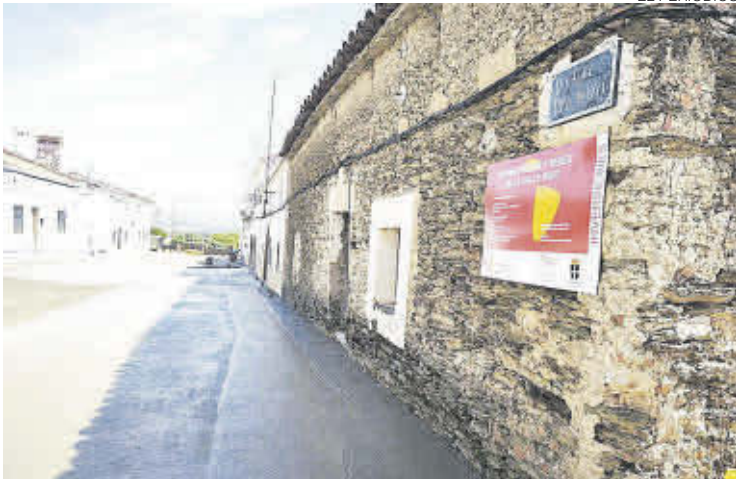
Las obras de la calle del Pozo han finalizado.
