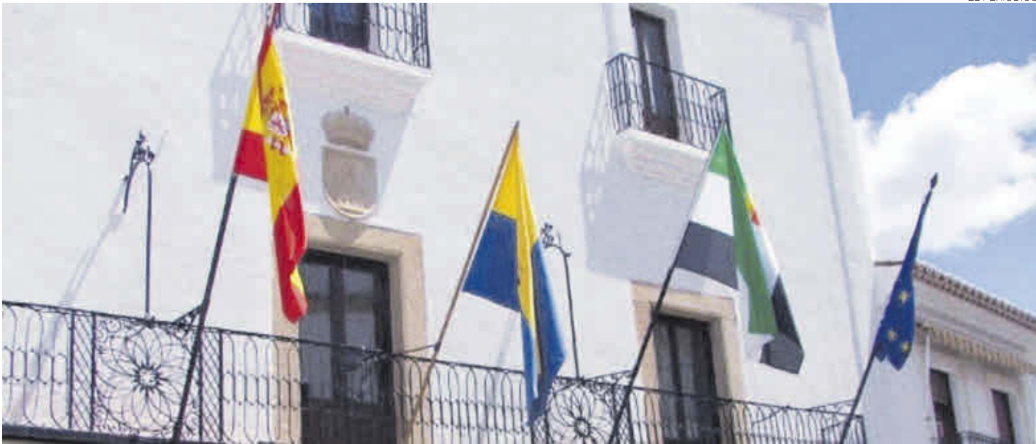
Fachada del Ayuntamiento de Malpartida de Cáceres.
