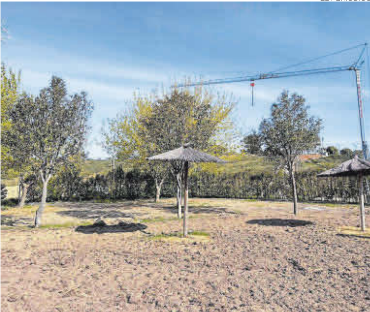
Los trabajos en la piscina municipal ya han comenzado.
