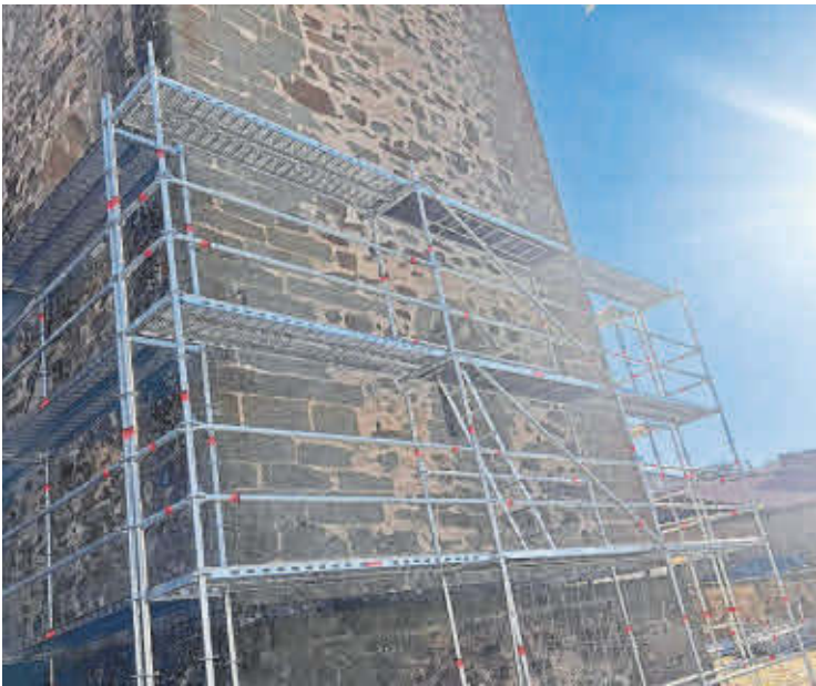
Ya ha comenzado el trabajo de mejorar de la torre de la iglesia.
