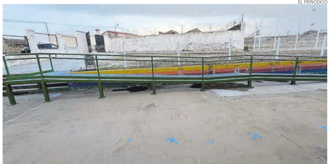
Rampa de acceso en el colegio del municipio.
