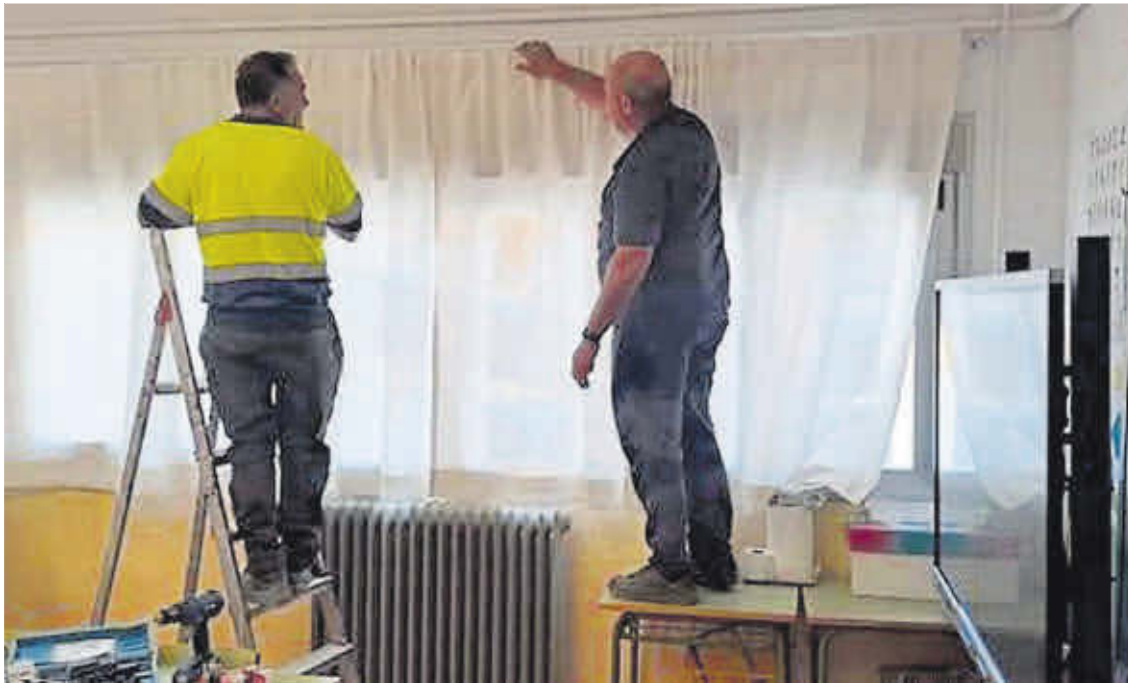
Operarios municipales colocan cortinas y aparatos de aire acondicionado.
