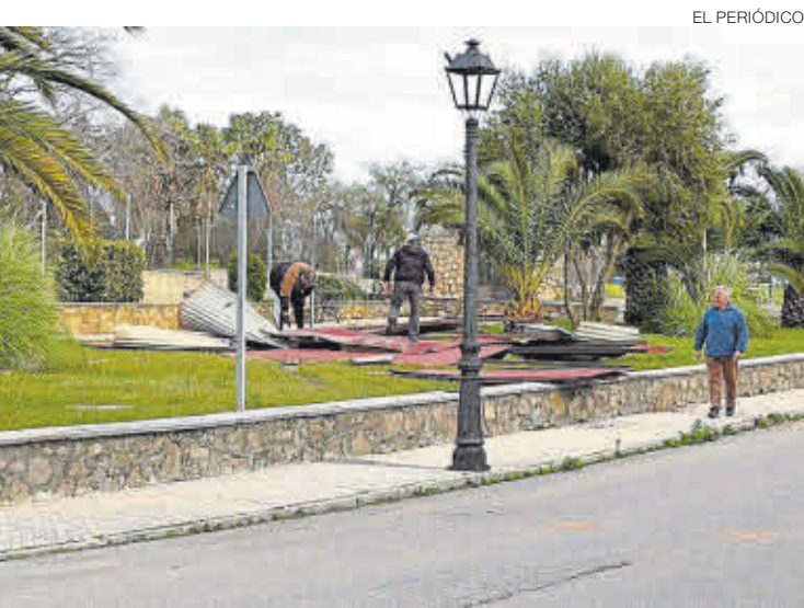
Zona afectada por el temporal.
