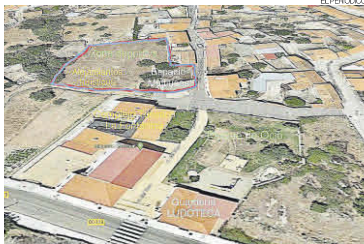
►► Terrenos sobre los que se ubicarán distintas infraestructuras.
