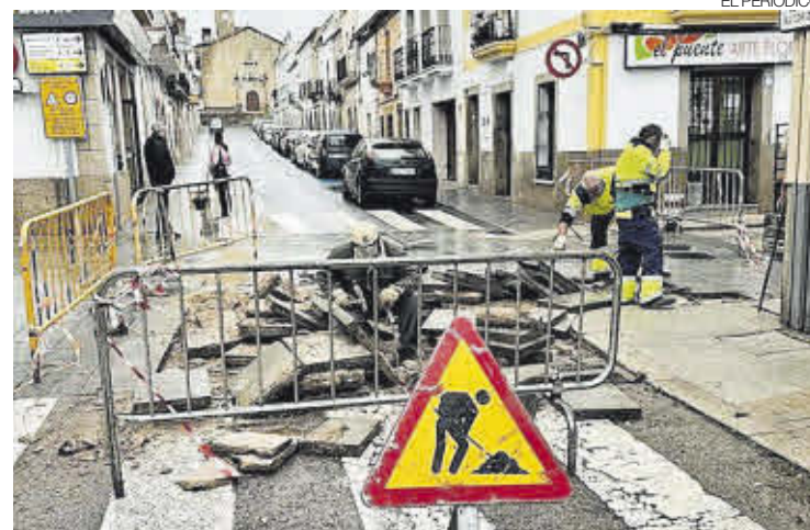
►► Dos operarios realizan trabajos en la zona afectada.
