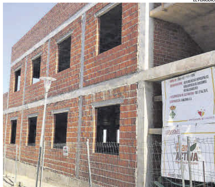
Construcción de la nueva residencia de ancianos de Navas.
