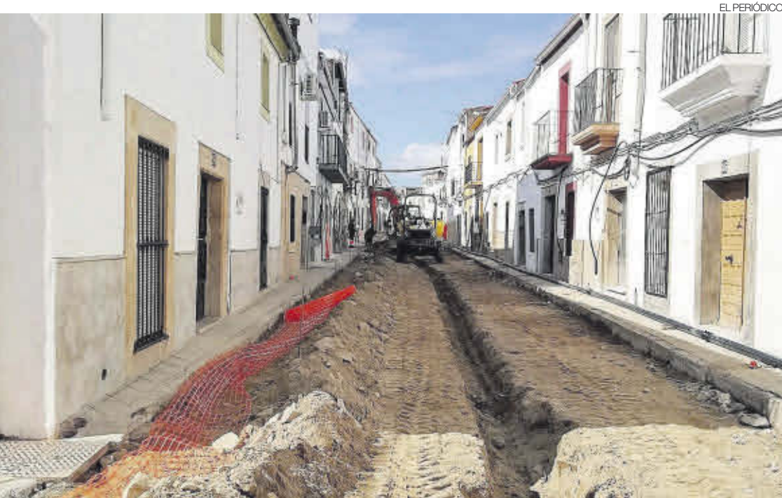
►► Obras que se ejecutan en la calle Vicente Chaparro de Navas.
