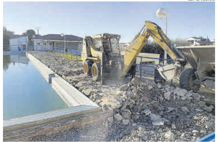
►► Una máquina trabaja en las obras de la piscina municipal.
