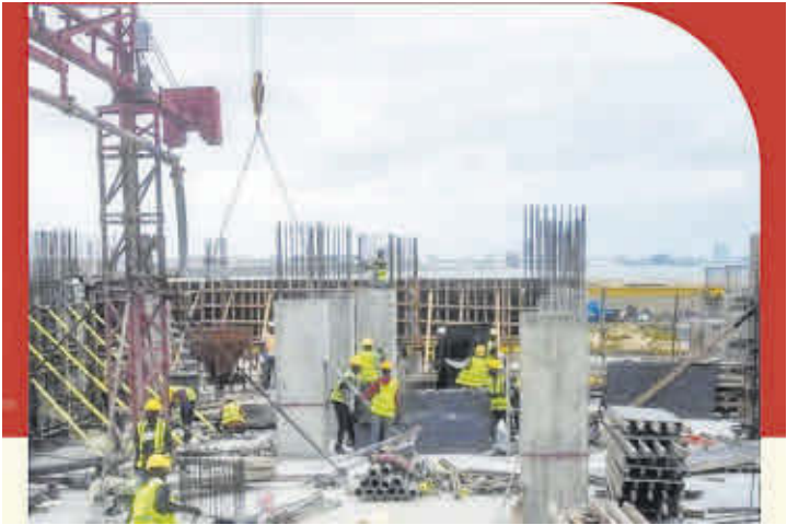
►► Varios operarios realizan trabajos en una obra en Casar.
