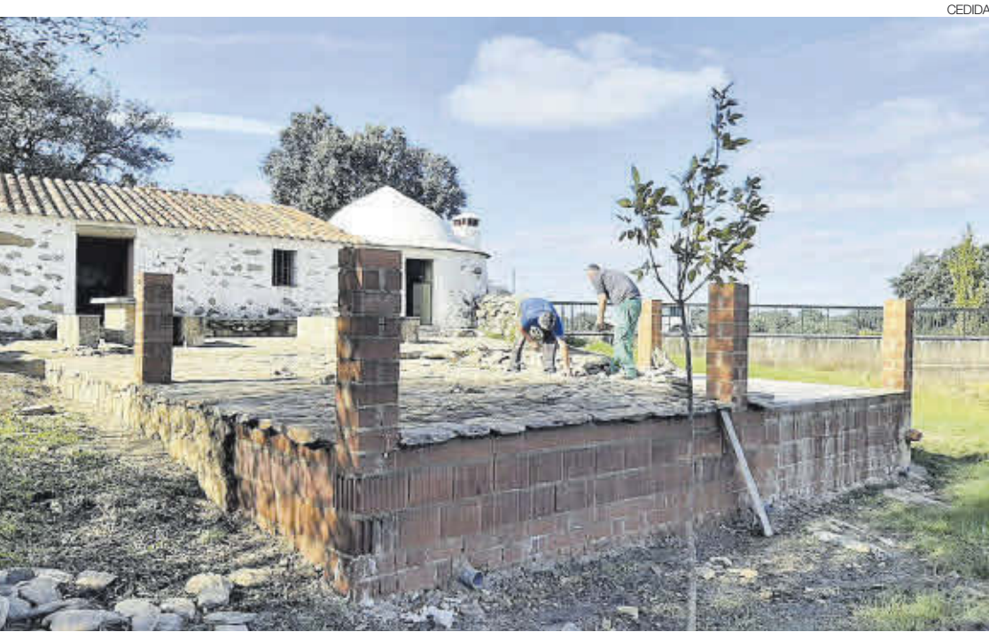
►► Dos vecinos de Mata trabajan en las obras de mejora de entornos que ya ha iniciado el ayuntamiento.
