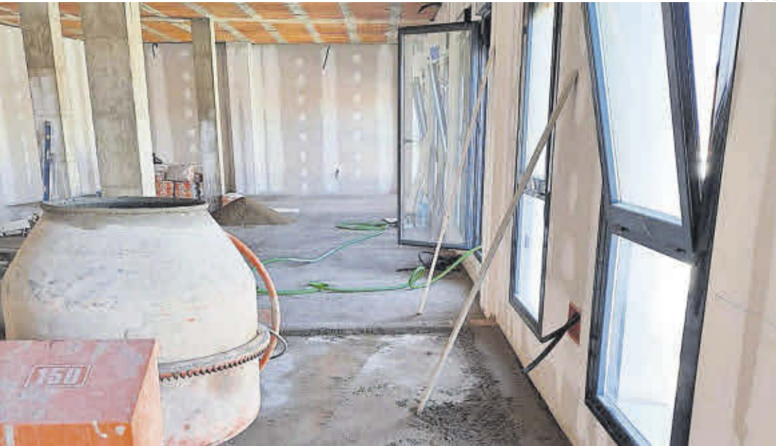
►► Obras que se acometen en la primera planta de la Casa de la Cultura de Piedras Albas.
