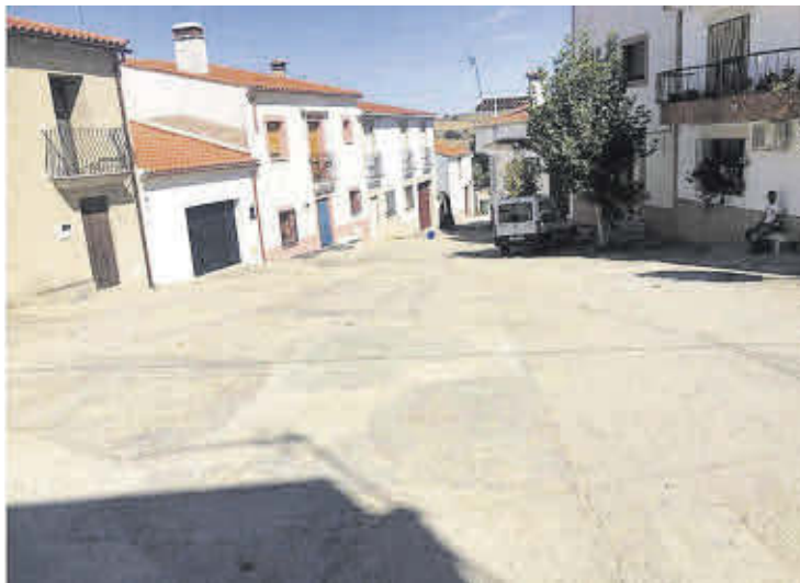
►► Estado actual de la zona de actuación de la calle Rivera.
