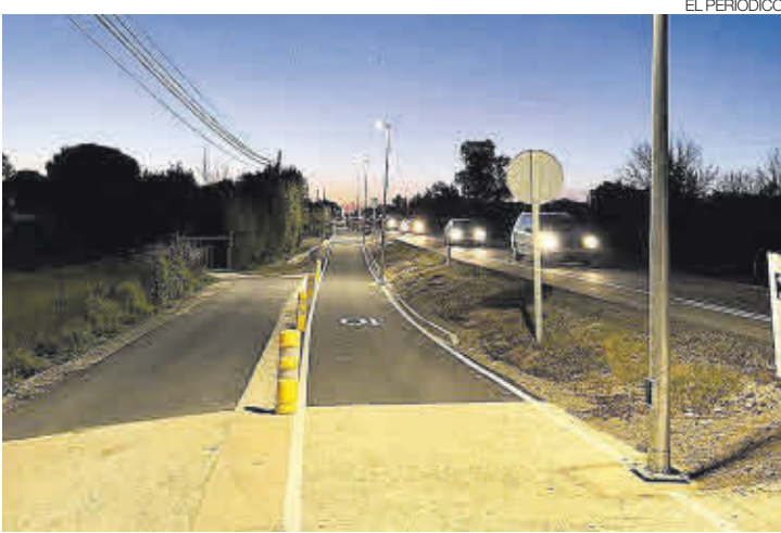
►► Camino peatonal, recién construido.
