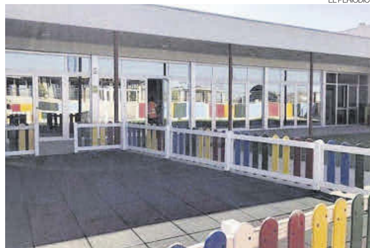
►► Instalaciones donde se desarrollan las actividades.
