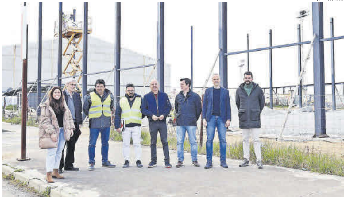
Alcalde y distintas autoridades locales y provinciales, junto a la nueva pista en obras.
