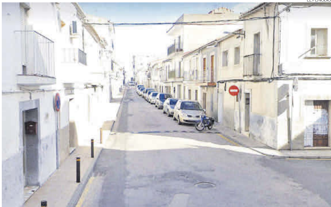
►► Una de las calles sobre las que se actuará para mejorar su pavimento y red de abastecimiento.
